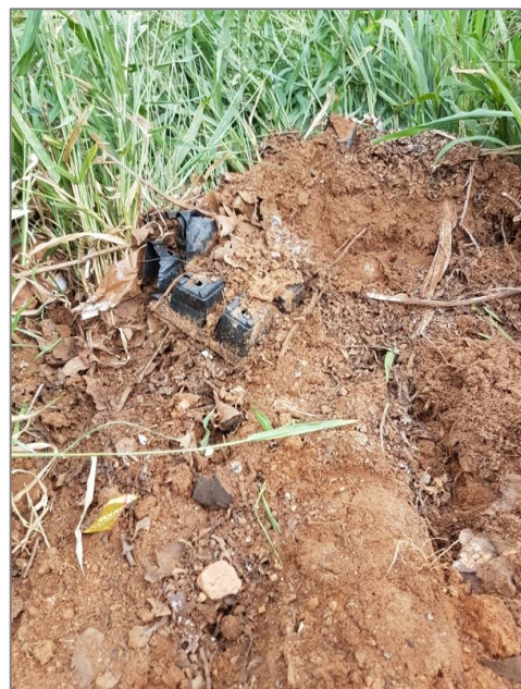
Test Pit no: TP21
