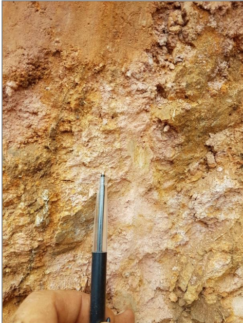
Test Pit no: TP15
