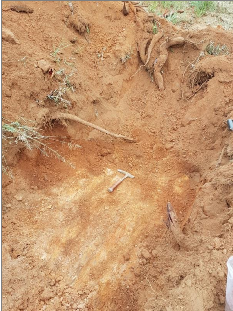
Test Pit no: TP18
